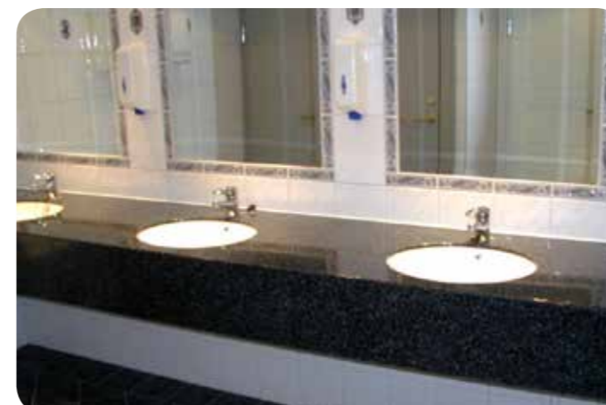
Spesiallaget servantløsning til en restaurant i Fagernes.
